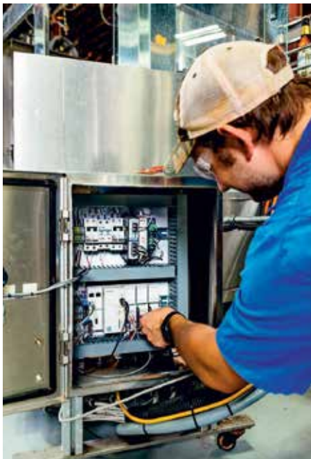
北卡罗来纳州的 Sugar Creek Brewing 公司使用 Bosch Rexroth 的物联网网关来监测、显示和控制其灌装线上罐子的压力和温度变化。结果，该公司减少了因环境因素造成的泡沫溢出，节省了资金，并将其工业 4.0 战略扩展到了酿造业务。
