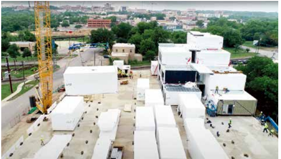
这些完成的模块单元是第 33 页所示的多户住宅楼的一部分，由 Z Mod 公司用模块化金属框架建造，并以 95% 的完成度交付给工地，每个单元的误差都在 1/16 英寸以内。(所有图片由 Z Mod 和 Bluco 提供)
